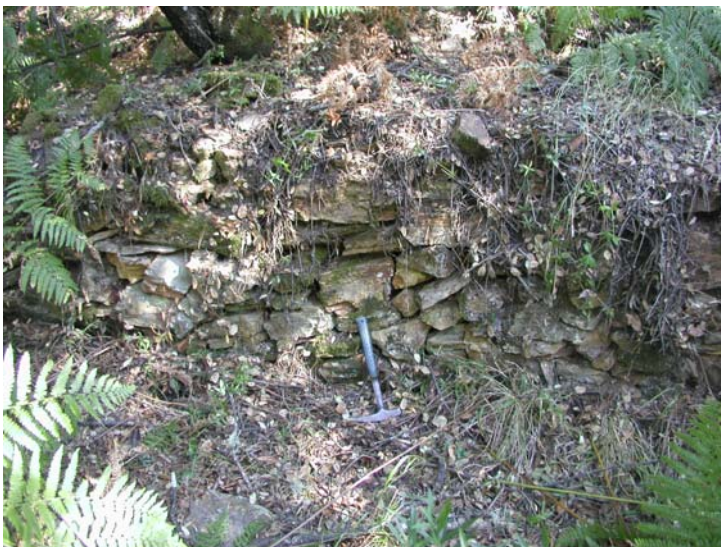
Fig. 4.138. Murete sobre el hastial
