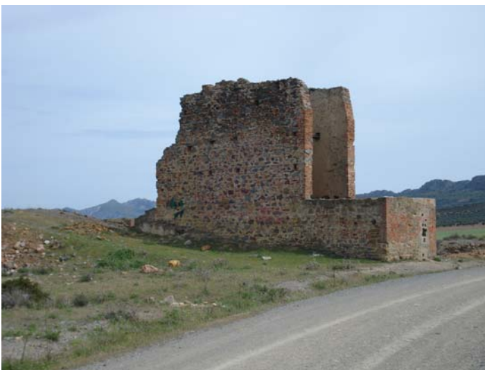
Fig. 4.79. Castillete y mampostería del pozo
