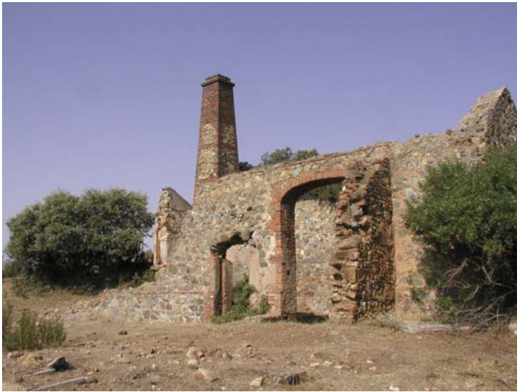
Fig. 4.66. Casa de máquinas. Pozo levante
