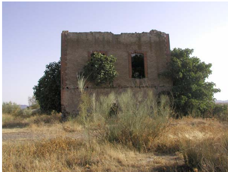
Fig. 4.94. Casa de máquinas
