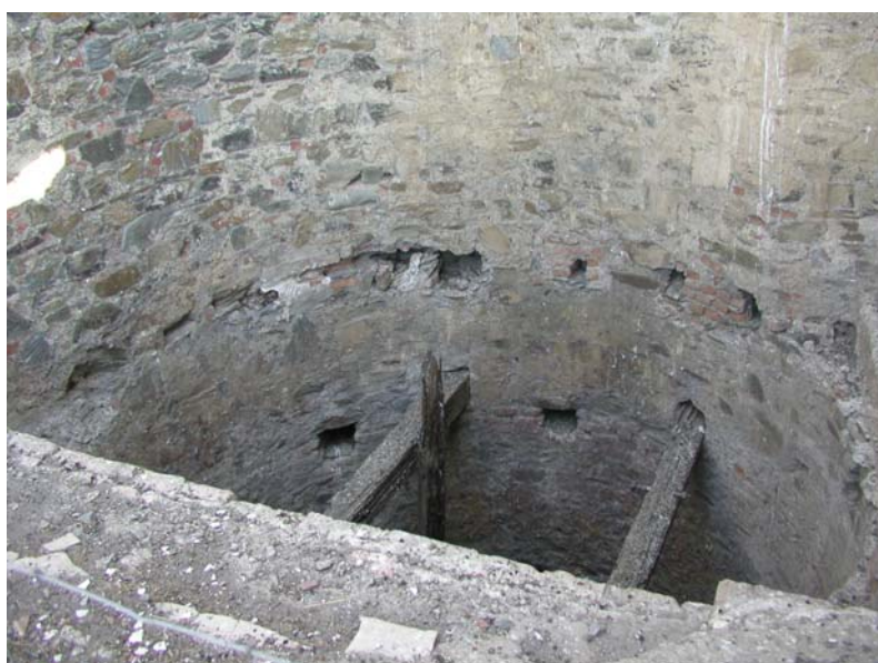
Fig. 4.92. Pozo y sus guideras de madera
