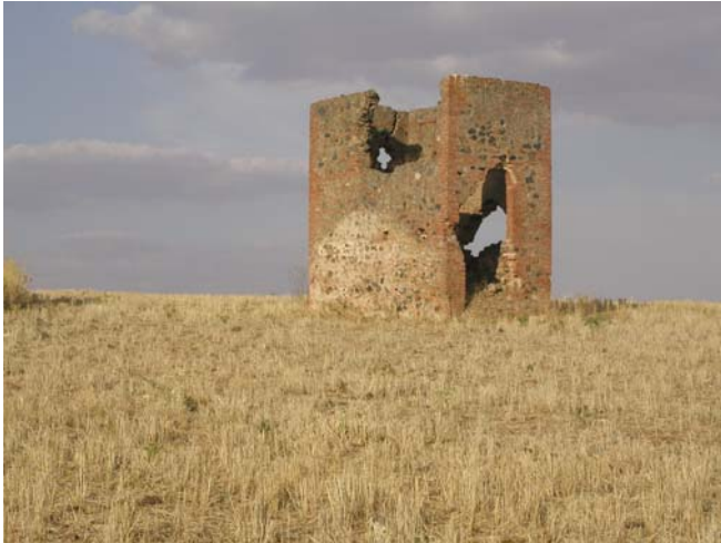
Fig. 4.28. Pozo San Gregorio
