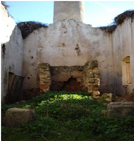
Fig. 4.43. Casa de calderas
