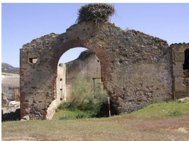
Fig. 4.172. Hueco de acceso
