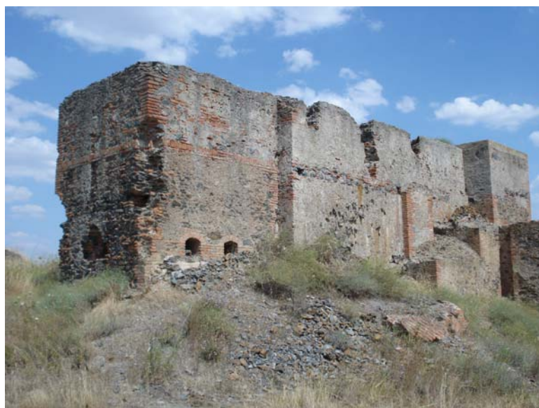
Fig. 4.4. Casa de máquinas del pozo San Juan
