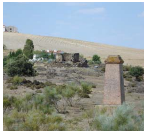
Fig. 3.13 Chimenea de ventilación
