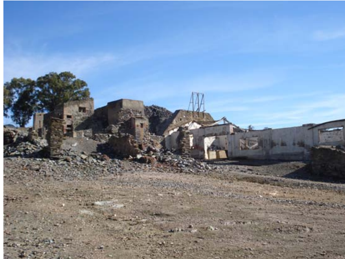
Fig. 4.181. Restos de las dos plantas de concentración
