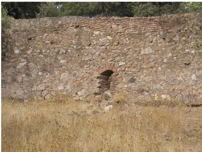
Fig.. 4.113. Registro del canal
