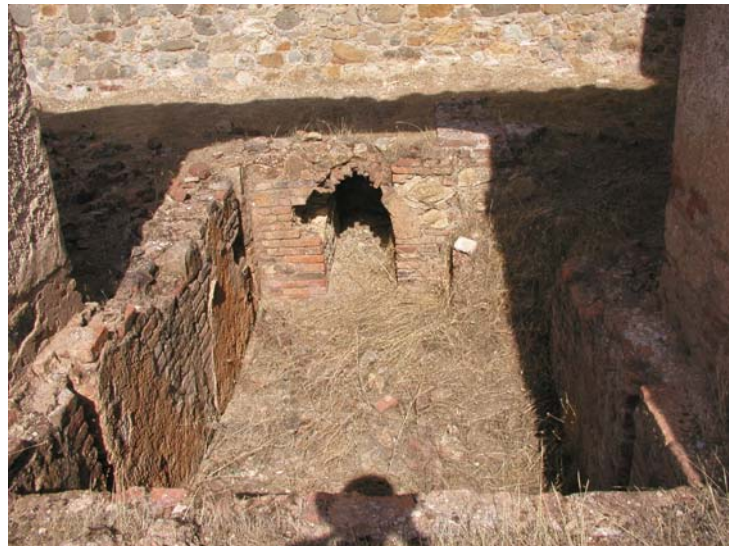
Fig. 4.67. Casa de máquinas. Paso para tuberías
