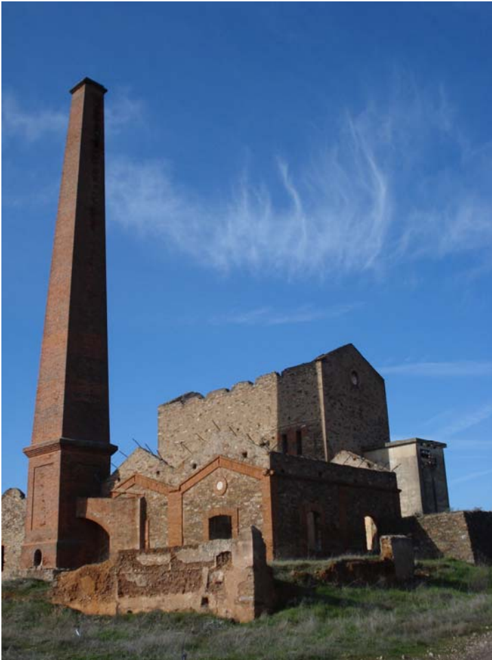
Fig. 4.61 Instalaciones del pozo Esmeralda
