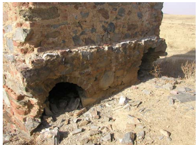
Fig. 4.85. Chimenea. Registros de tiro
