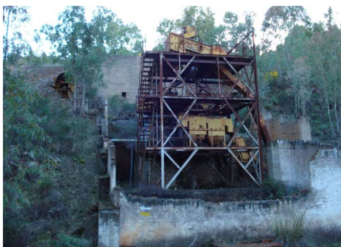
Fig. 4.190. Instalación hidroclasificadora para el lavado de terreras
