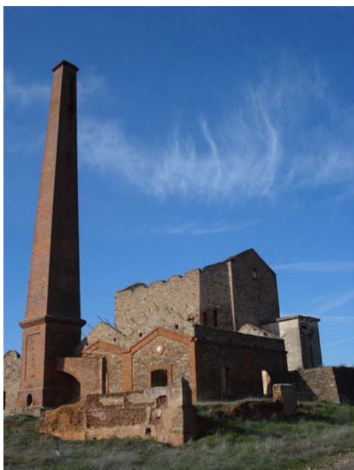
Fig. 3.14 Casa de máquinas. Filón Esmeralda (Aldea Moret)
