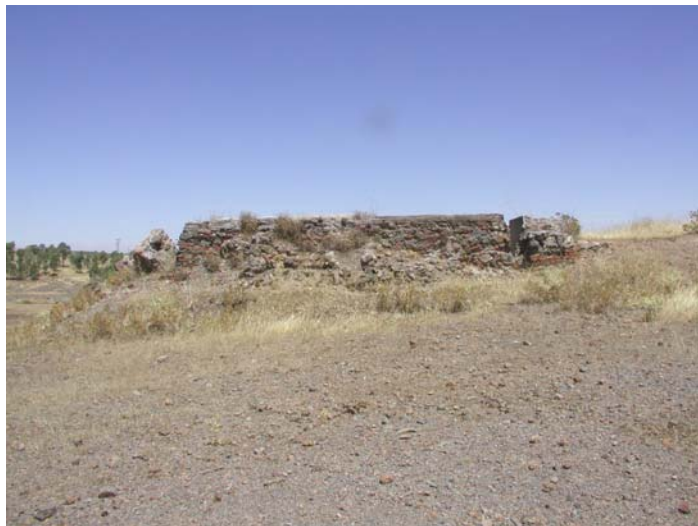
Fig. 4.20. Instalación del pozo a levante
