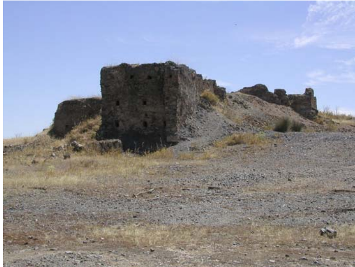
Fig. 4.19. Instalación del pozo a poniente
