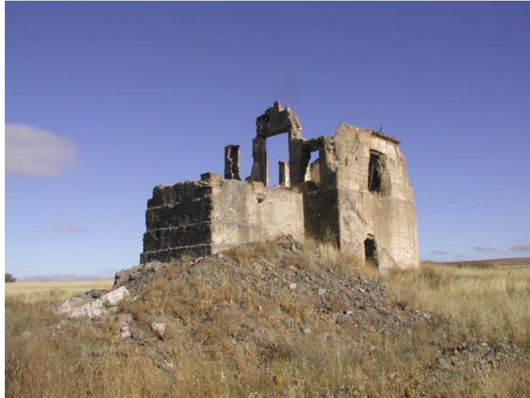
Fig. 4.5. Casa de máquinas del pozo Salomón
