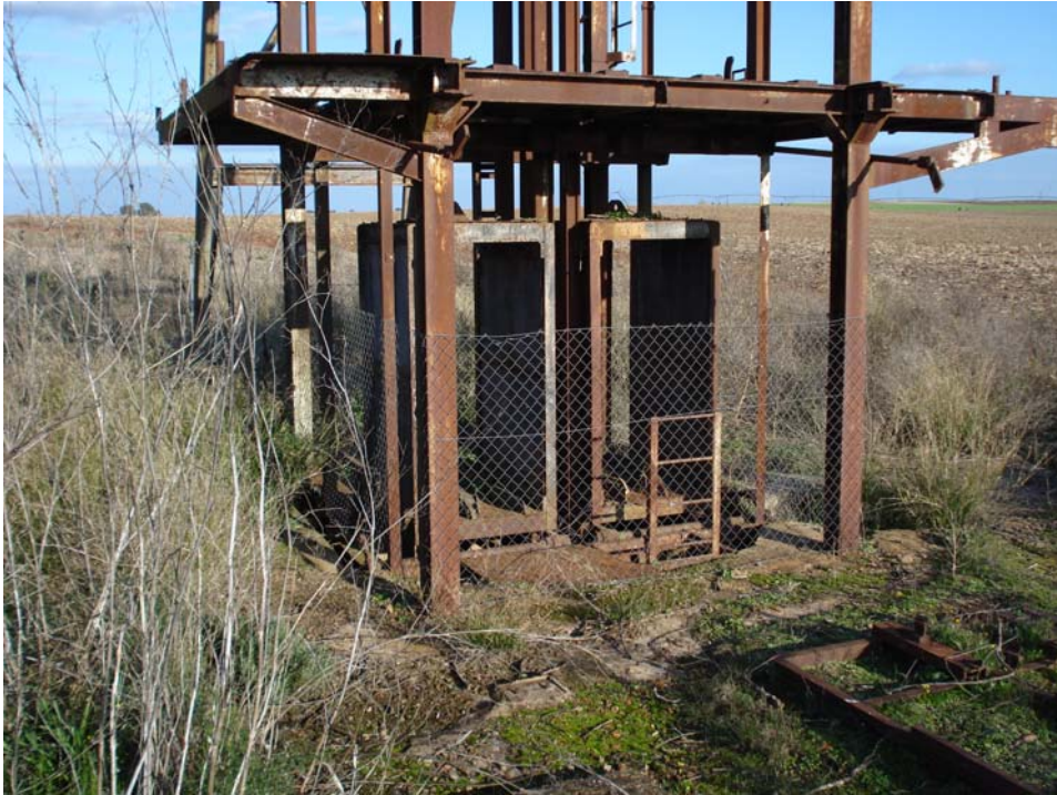
Fig. 4.76. Enganche al pozo y jaulas
