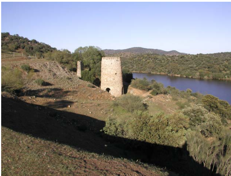
Fig. 4.107. Horno y apoyo de la plataforma de carga
