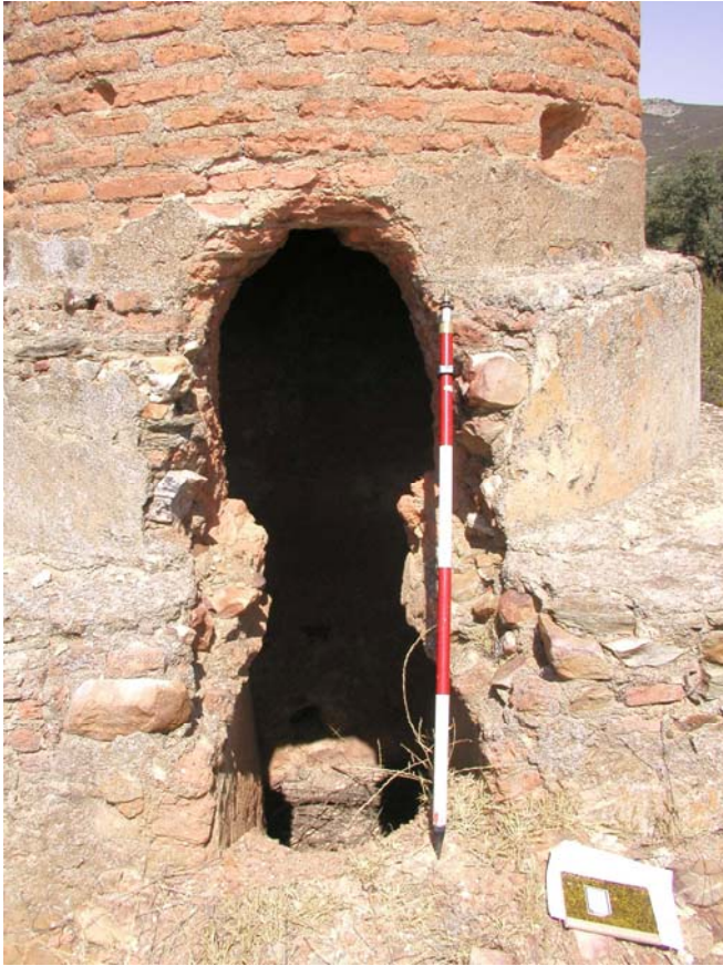
Fig. 4.119. Conexión del canal de humos
