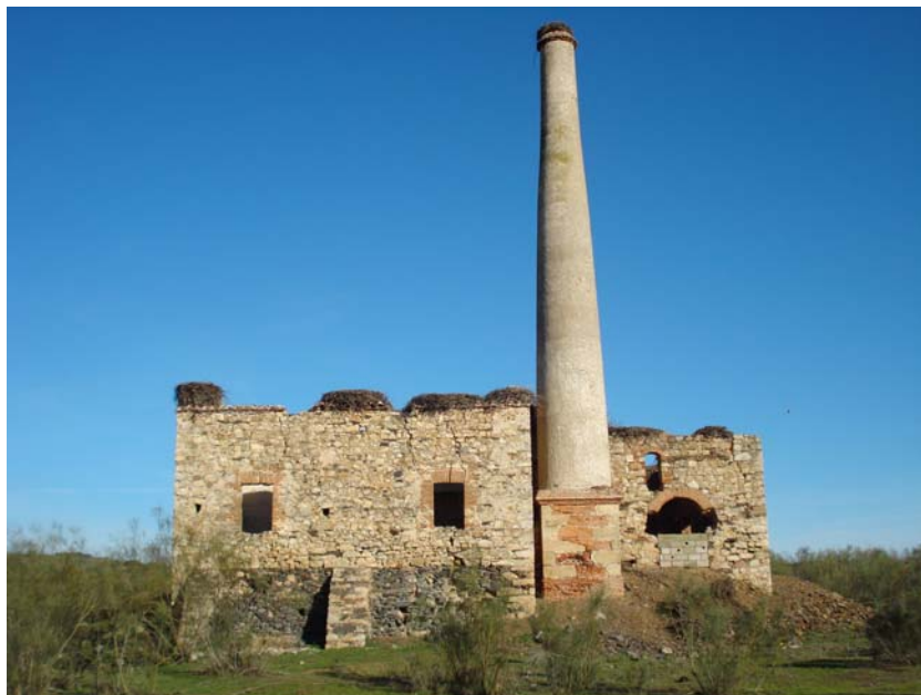
Fig. 4.41. Casa de máquinas
