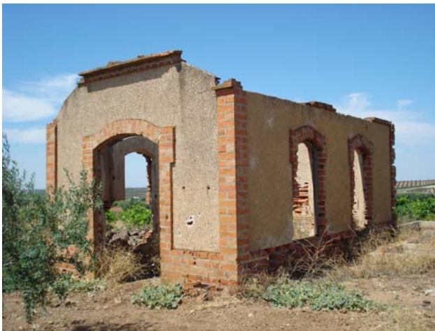
Fig. 4.124. Casa de máquinas
