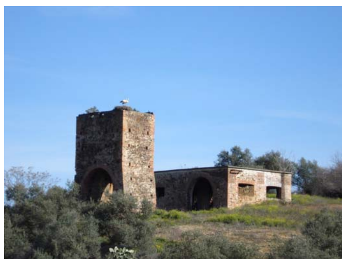
Fig. 4.97. Pozo Calle, castillete y sala de máquinas
