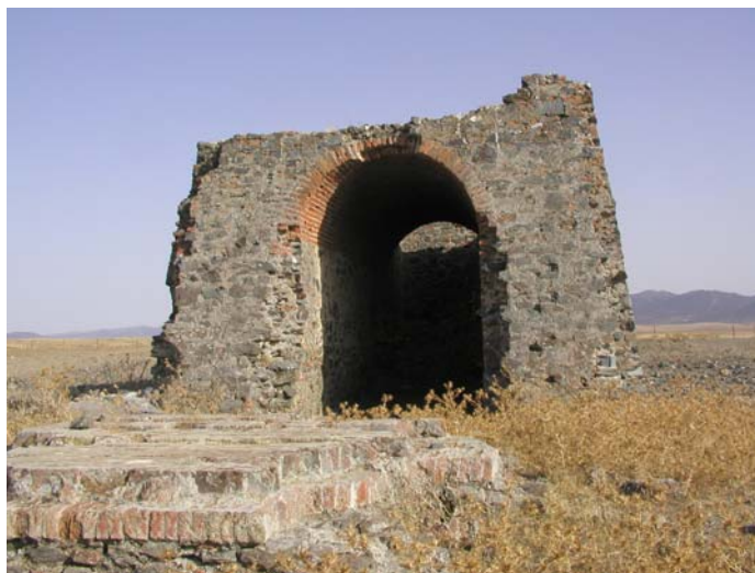
Fig. 4.89. Asiento máquina y acceso al pozo
