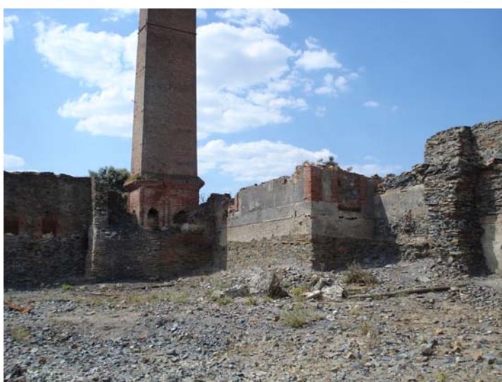
Fig. 4.15. Instalaciones pozo San José
