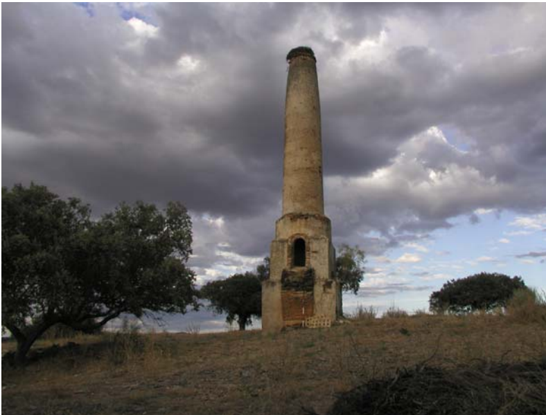
Fig. 4.37. Chimenea de la fundición
