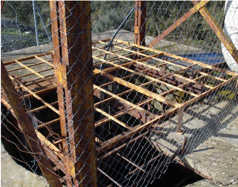
Fig. 4.70. Enganche del castillete al pozo
