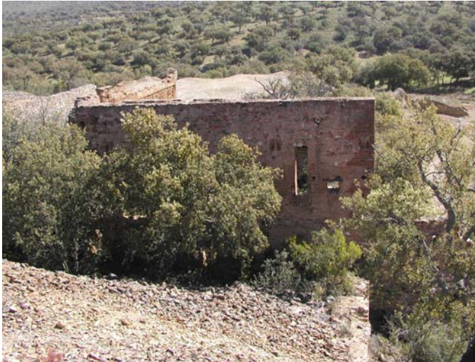
Fig. 4.166. Casa de máquinas
