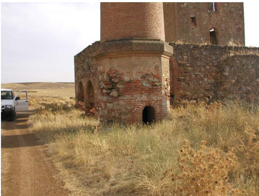
Fig. 4.24. Casa de calderas y base de la chimenea
