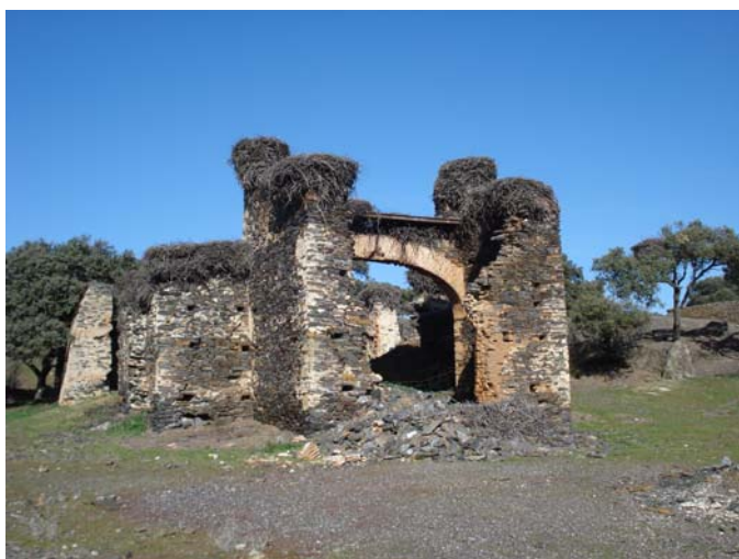
Fig. 4.34. Cabria del pozo II
