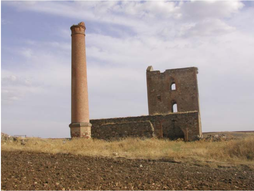
Fig. 4.23. Casa de máquinas
