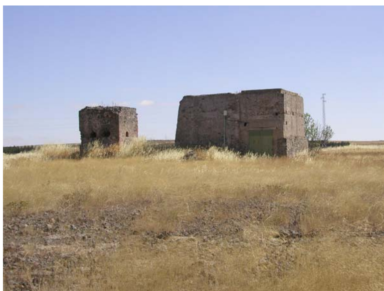
Fig. 4. 8. Casa de máquinas
